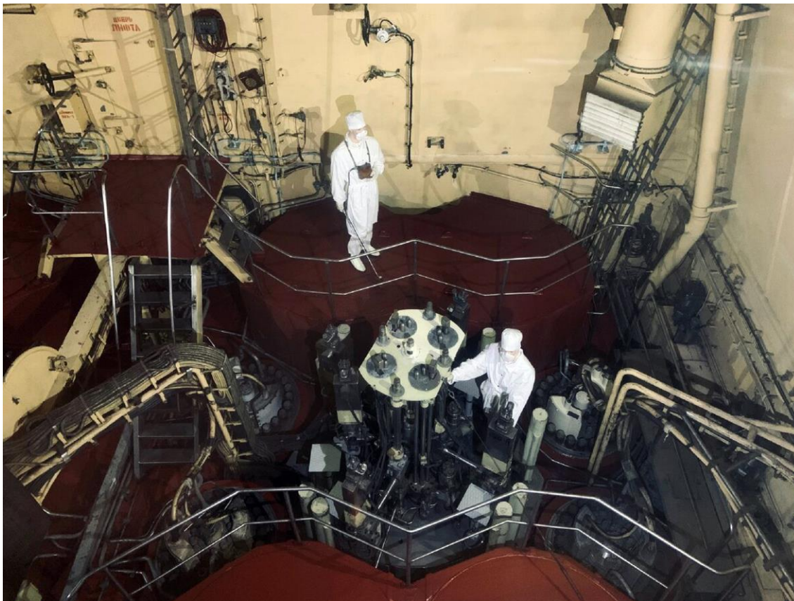
Реакторный отсек ледокола «Ленин»
